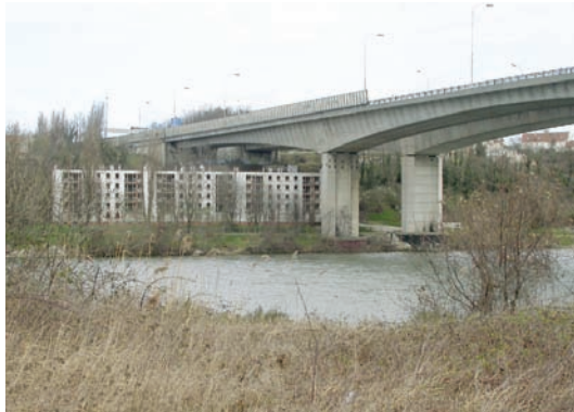
Site du Port à Sable sur les berges d'Argenteuil et ancien foyer Sonacotra aujourd'hui démoli. © EBR, IAU îdF, 2008
